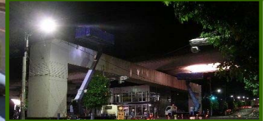
高所作業車による橋梁点検
