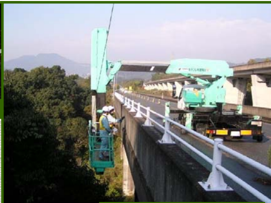
橋梁点検車による橋梁点検
