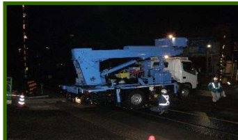
踏切からの軌陸車搬入
