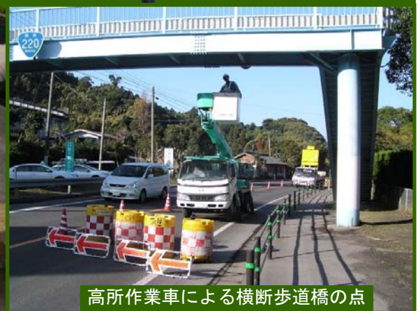
橋梁点検車による橋梁点検
