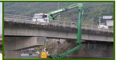
橋梁点検車による橋梁点検
